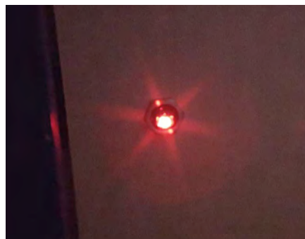
Die Schaltung der Treppenbeleuchtung erfolgt über eine Reflexionslichtschranke
