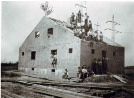
Bild: Erster Bauabschnitt, wahrscheinlich Stallagsweg Foto: Siedlergemeinschaft
