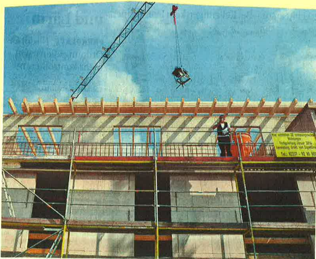
Am Freitagmittag wurde das Richtfest der Seniorenwohnungen an der Peter-Achnitz-Straße in Niederaußem gefeiert.
